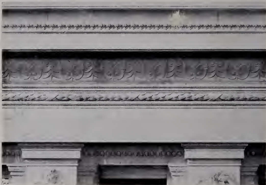
137. — Cornice dei muri perimetrali
